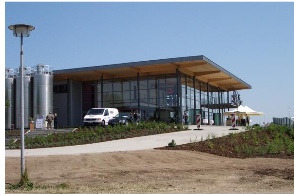
Bäckereitechnologische und technische Begleitung beim Neubau des Produktions- und Verwaltungsgebäudes leistete ELEKOM Technik aus Buchholz / Nordheide.
